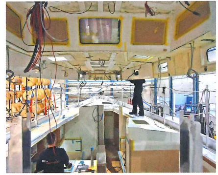
6) Vorbereiteter Aufbau wird eingeschwebt.
