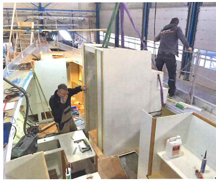
8) Duschkabinenblock wird eingesetzt.
